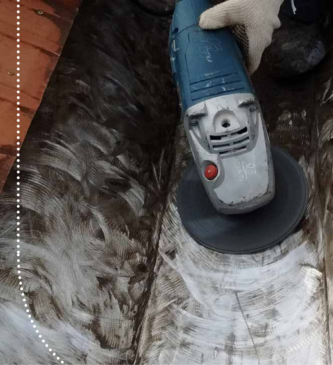
Preparação da área: Lixamento e limpeza da calha, removendo contaminações
