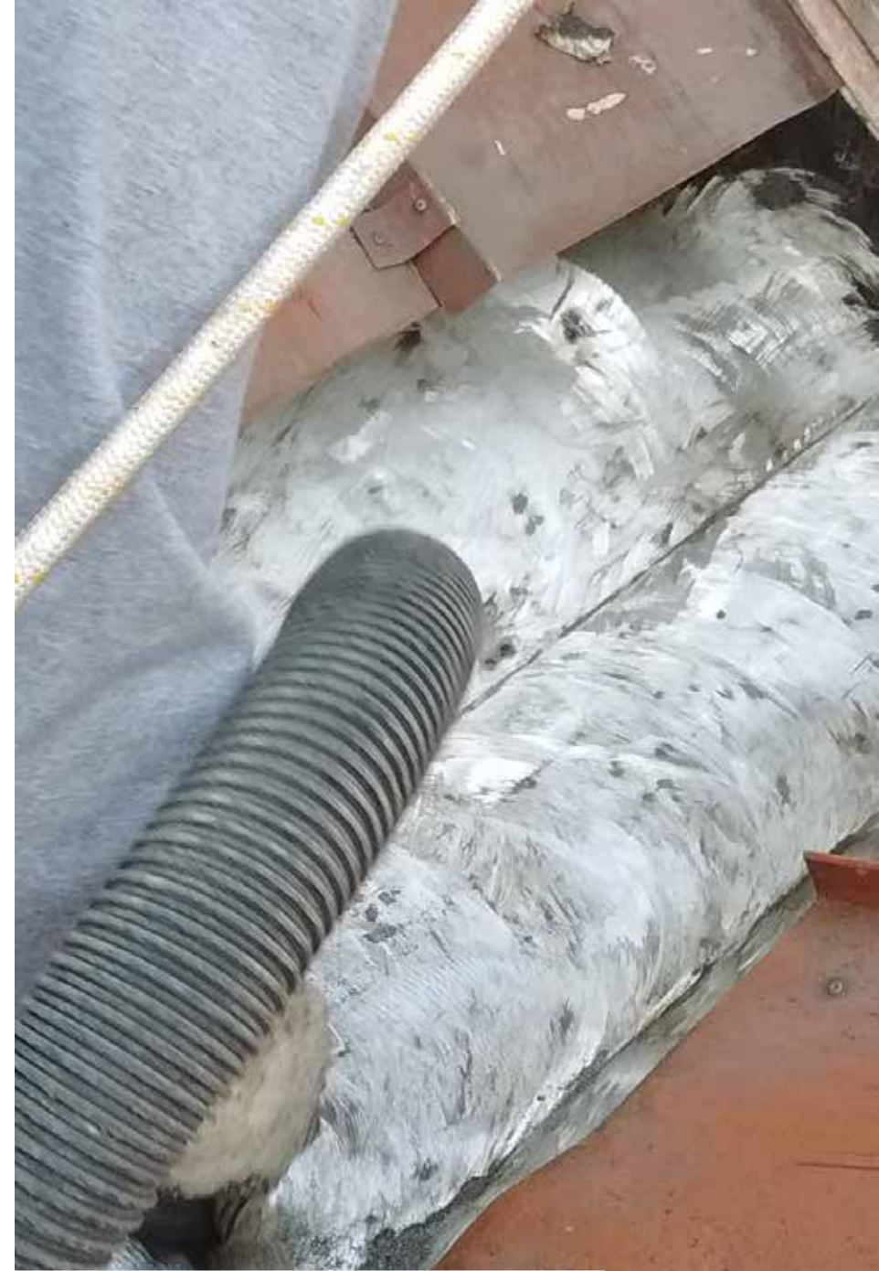
Preparação da área: Lixamento e limpeza da calha, removendo contaminações
