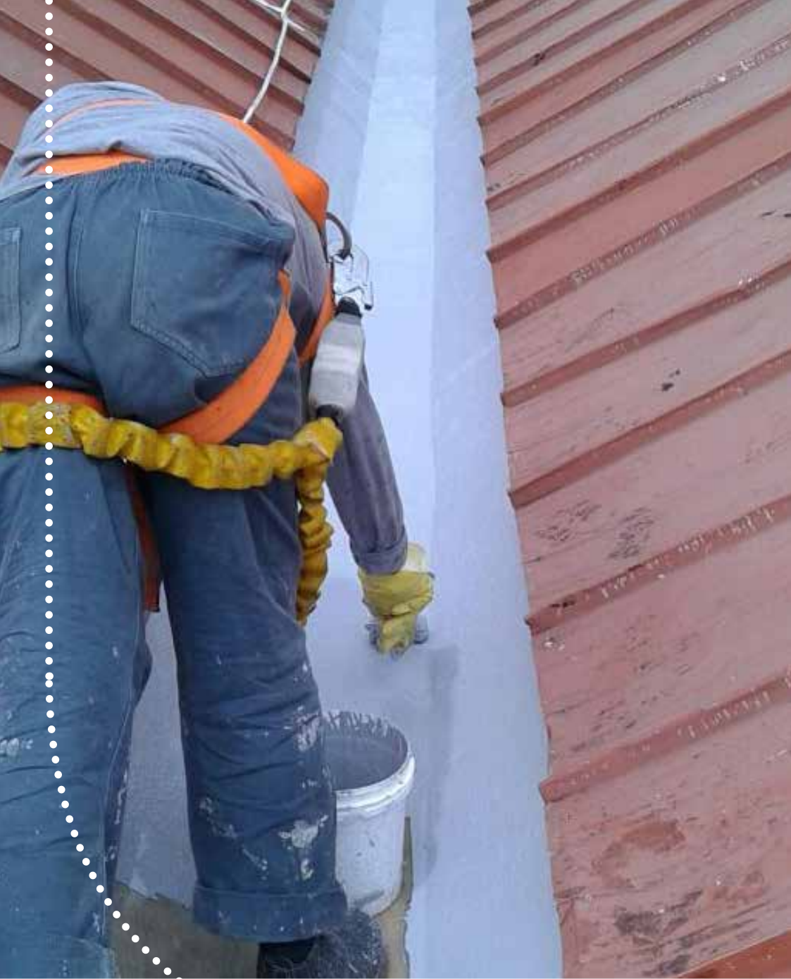
Acabamento: Aplicação do acabamento PMMA
