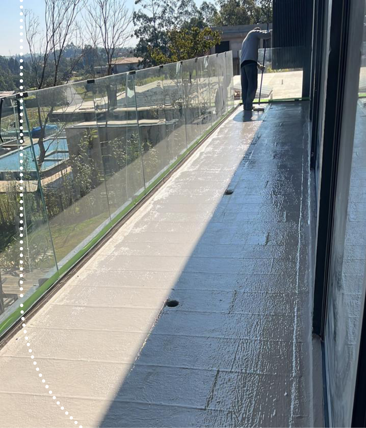
Acabamento: Aplicação do acabamento PMMA
