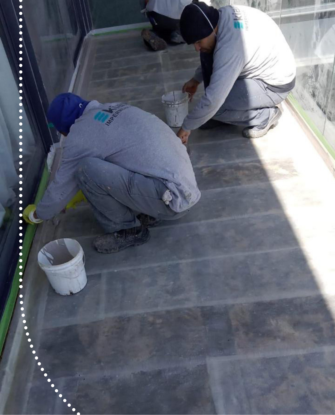
Membrana PMMA: Aplicação da membrana PMMA com tecido estruturante em toda a base
