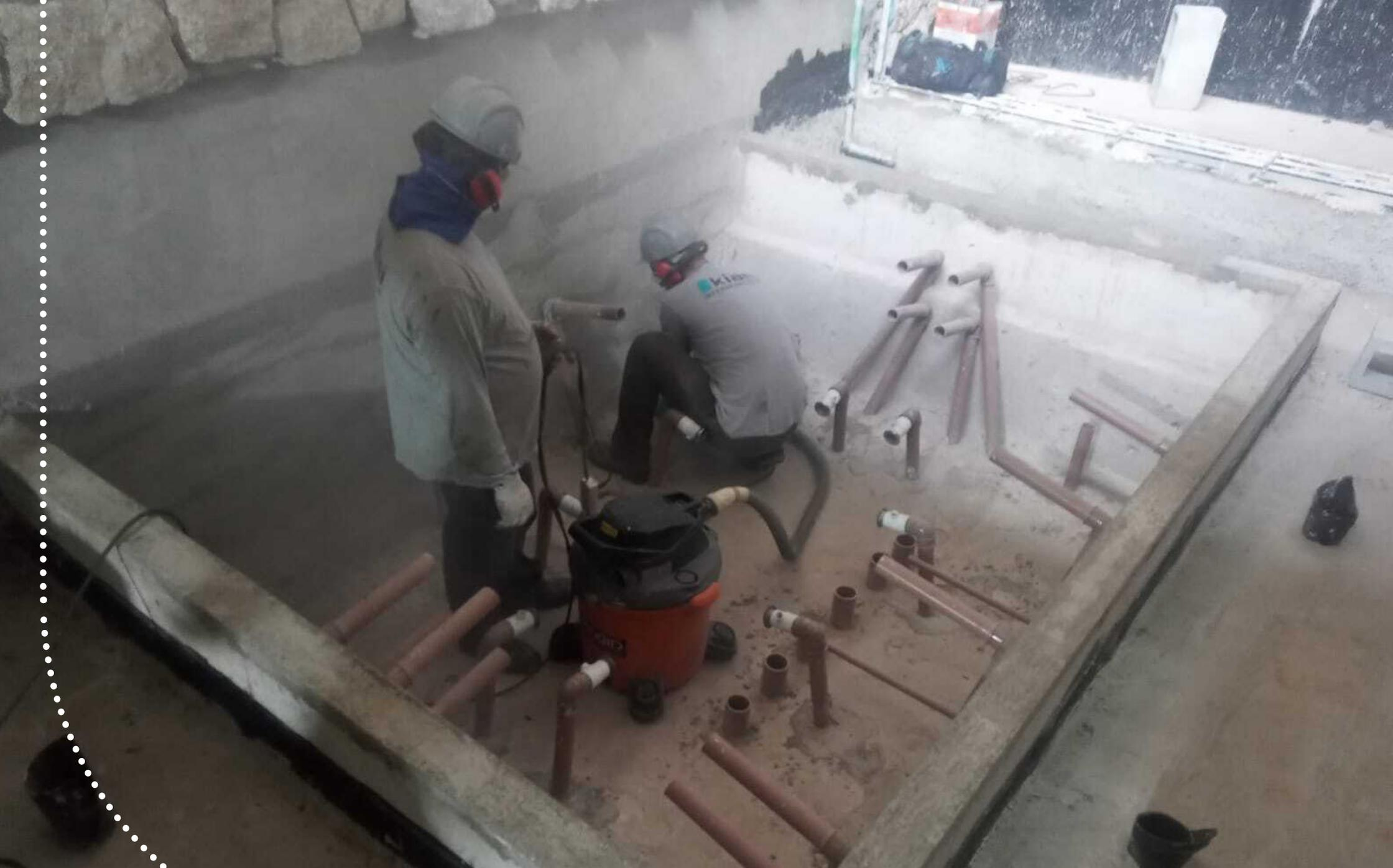
**Preparação da base:** Lixamento para abertura do perfil de ancoragem
