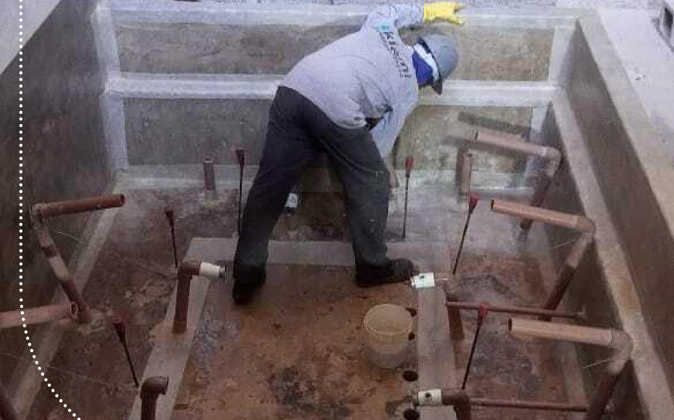
**Membrana PMMA:** Aplicação da membrana PMMA
