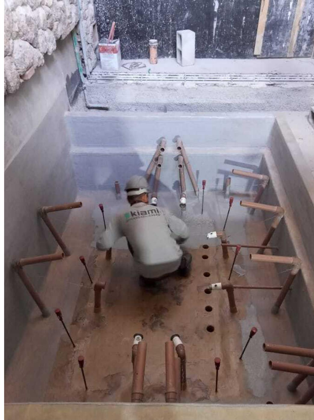
**Acabamento:** Aplicação do acabamento PMMA aspergido com quartzo
