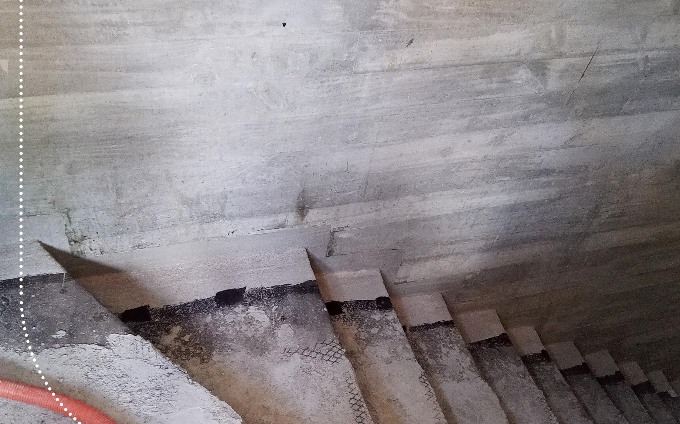
**Acabamento:** Aplicação do acabamento PMMA no perímetro da área
