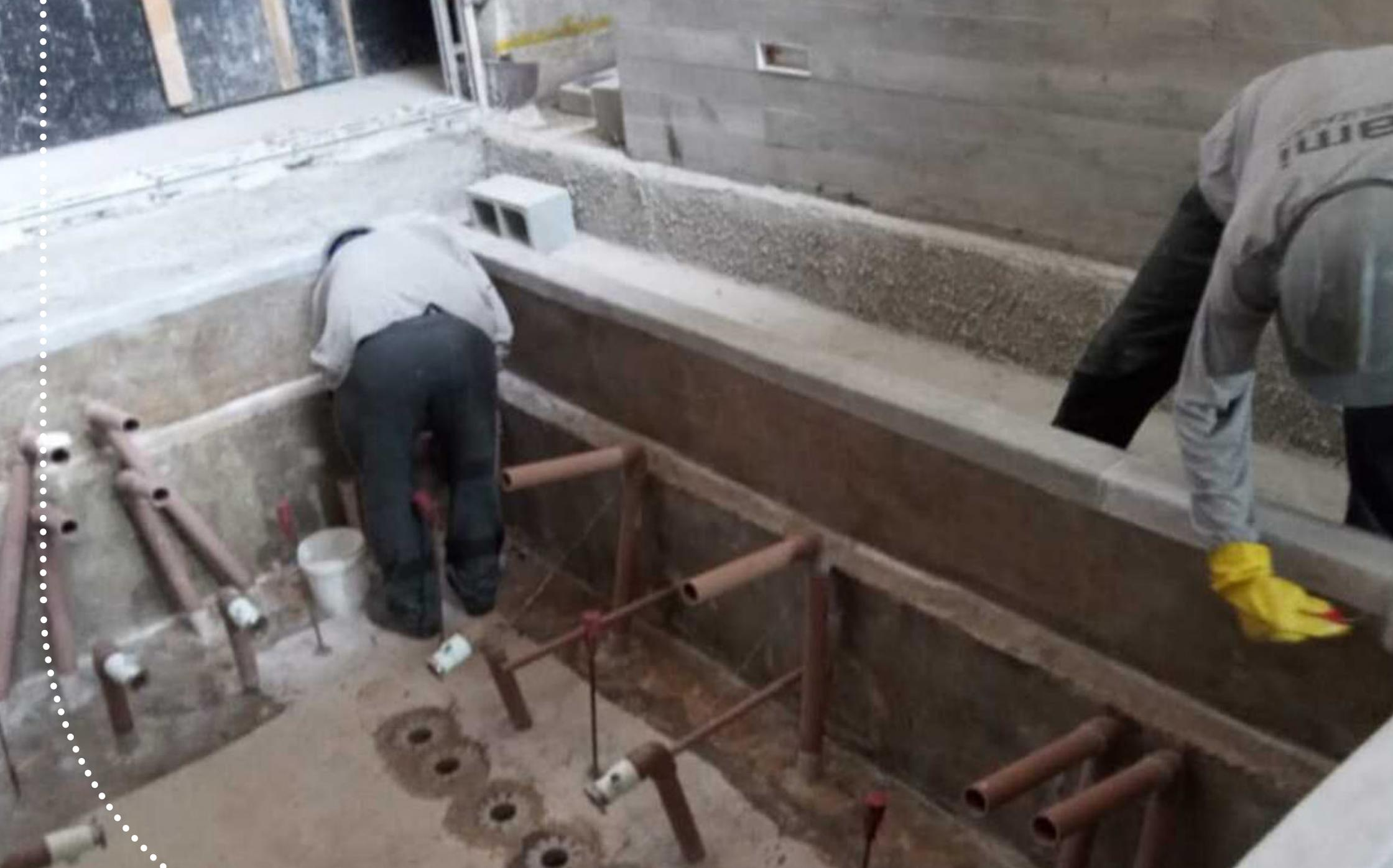
**Arremates:** Aplicação do tecido estruturante em rodapés e pontos de fragilidade
