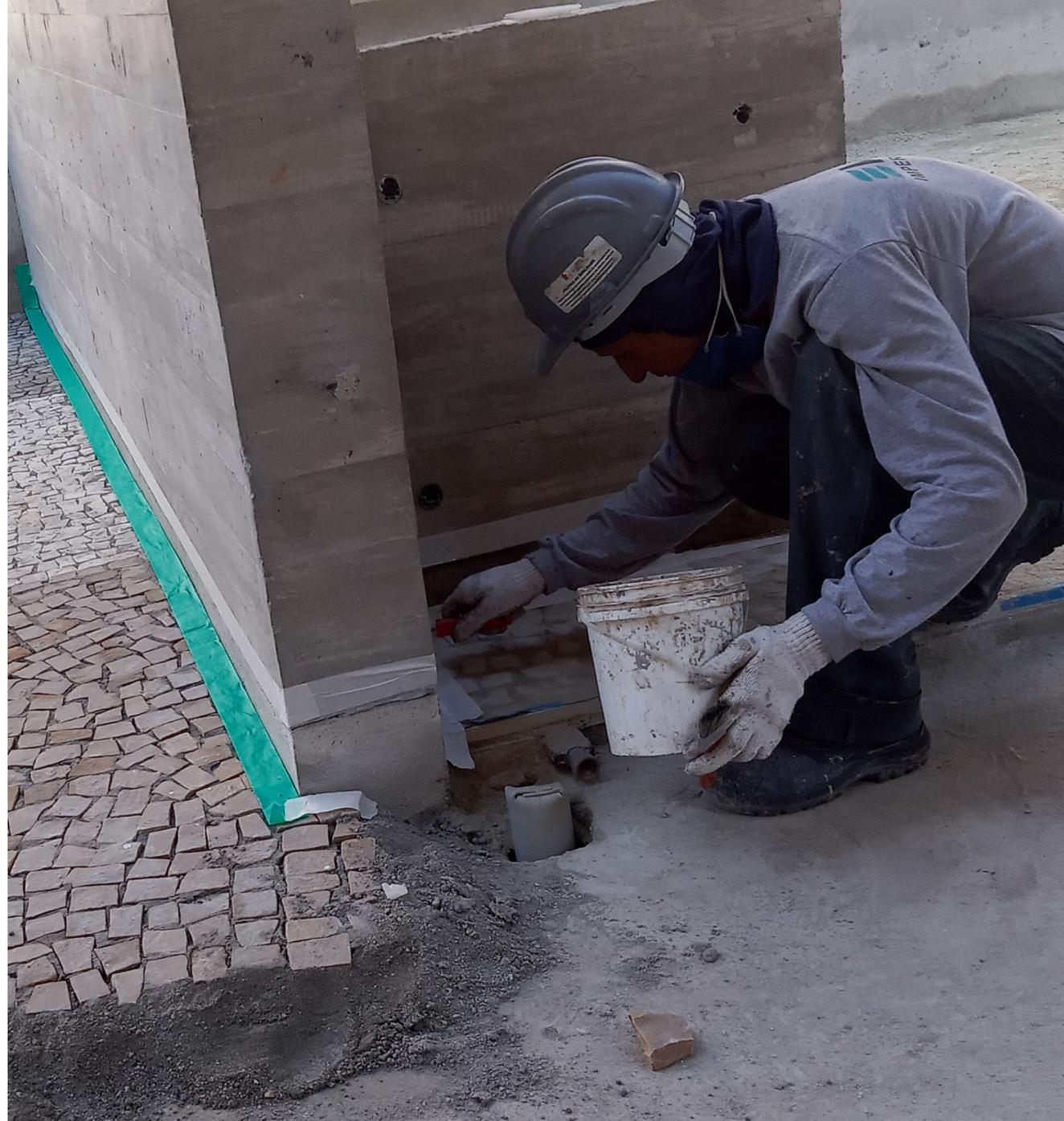
**Arremates:** Aplicação do tecido estruturante em rodapés e pontos de fragilidade
