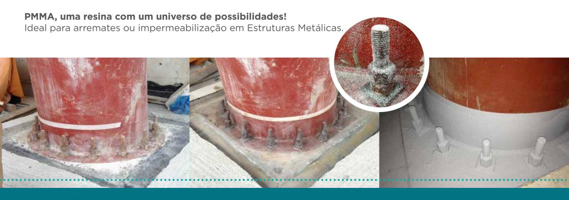
O PMMA tem aderência perfeita a diversos tipos de substratos, principlamente estruturas metálicas. Com fusão química entre camadas e as demais características das resinas Duraline, fazem deste sistema de impermeabilização o mais confiável do mercado para arremates de estruturas e integração com outros sistemas que não permitem arremates finos e complexos ou não garantem aderência sobre estruturas metálicas.
