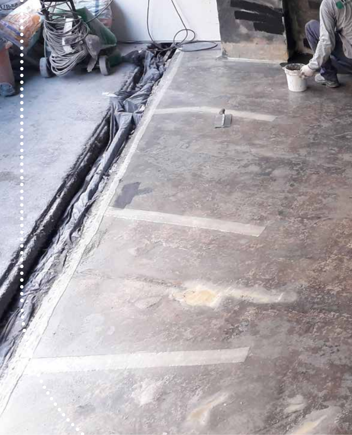
Arremates: Aplicação do tecido estruturante em trincas e bordas da canaleta
