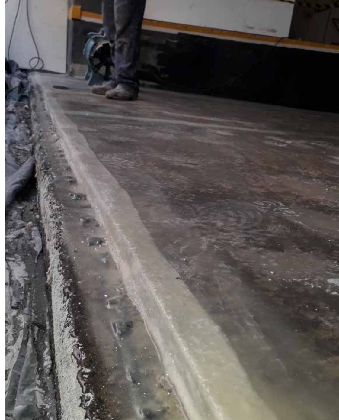
Arremates: Aplicação do tecido estruturante em trincas e bordas da canaleta
