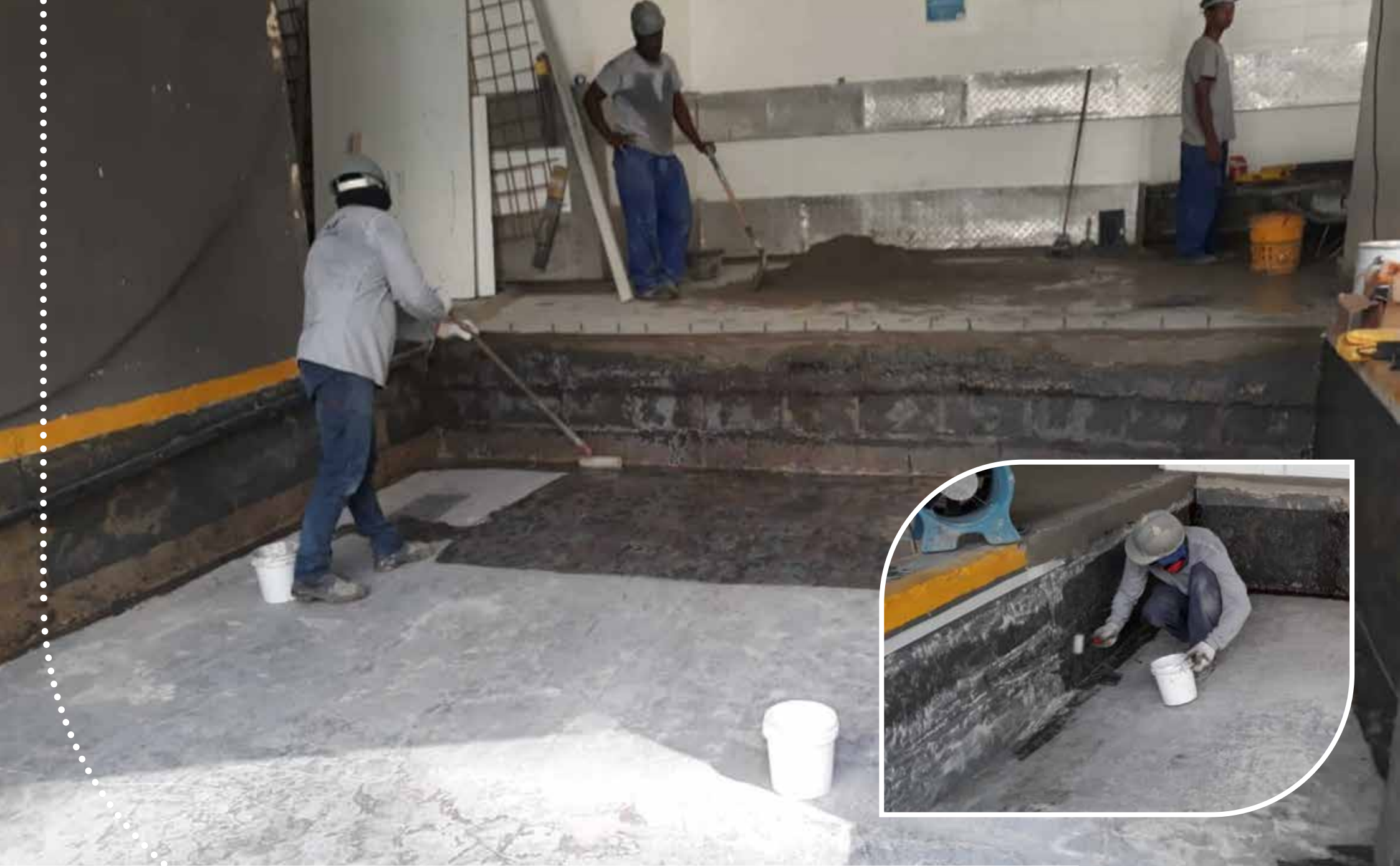
Primer: Aplicação do primer PMMA, selando a porosidade da base
