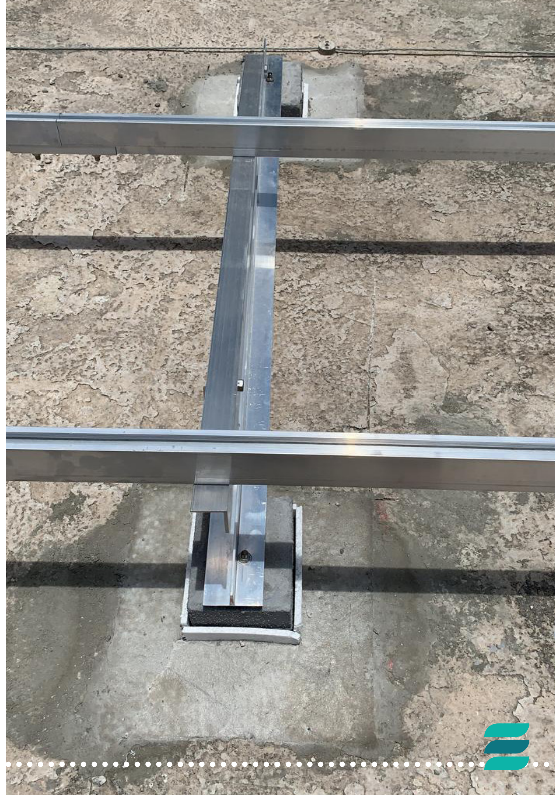
Fixação das estruturas das placas solares
