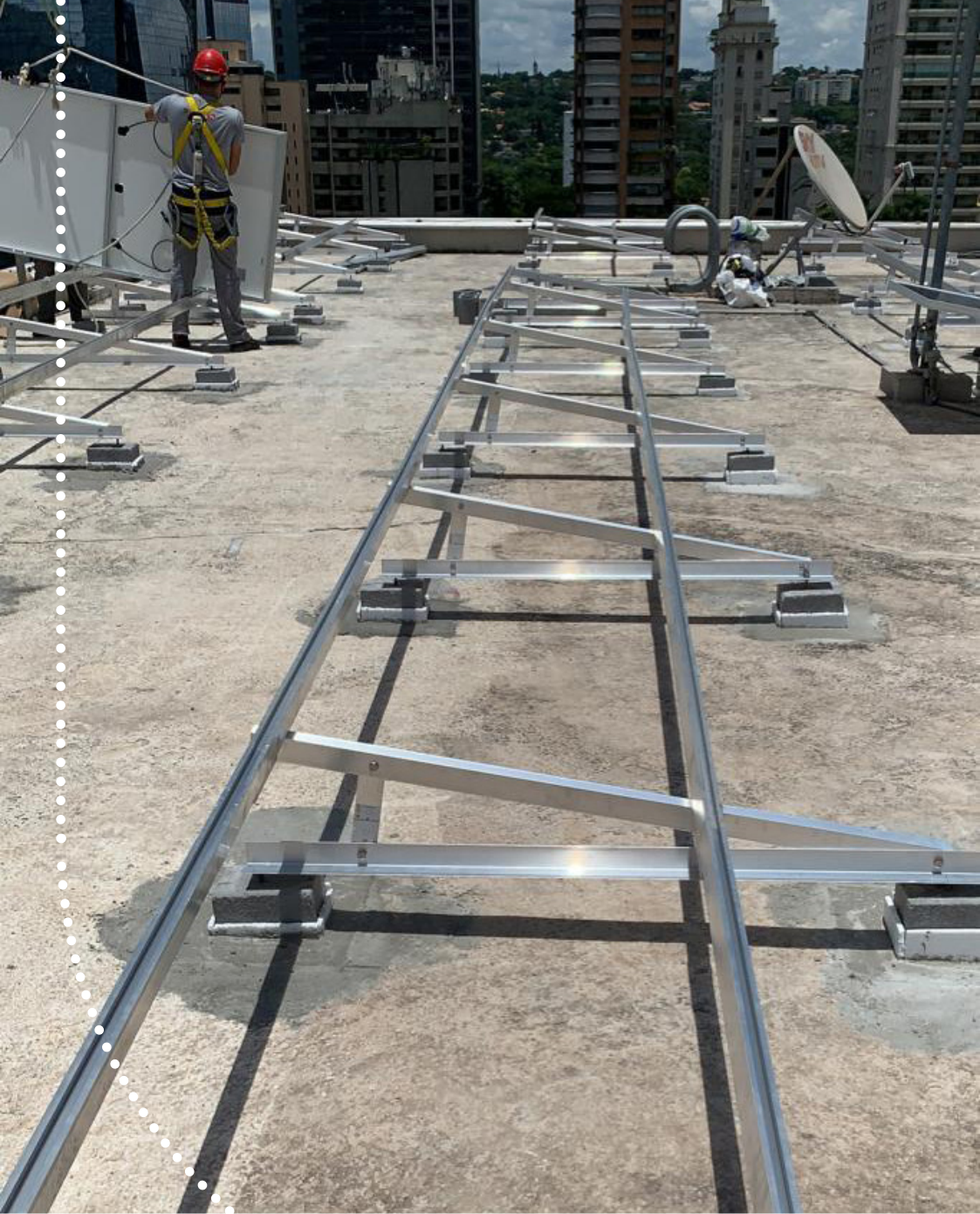
Fixação das estruturas das placas solares
