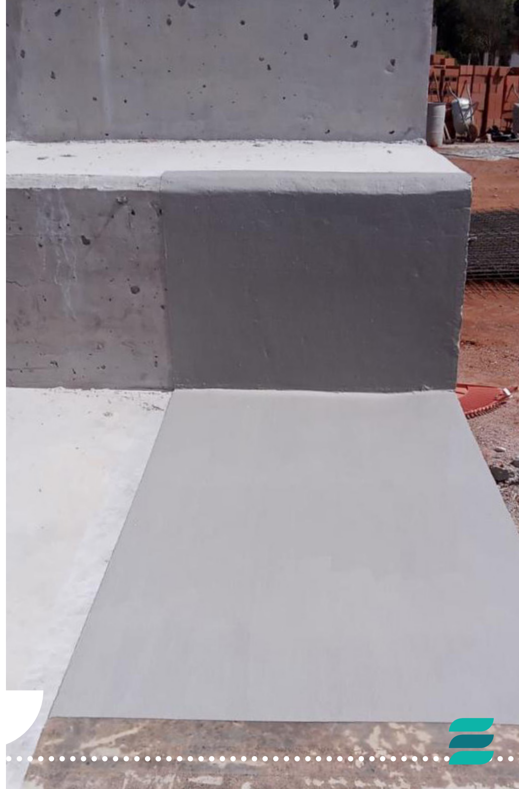
Acabamento: Aplicação do acabamento PMMA
