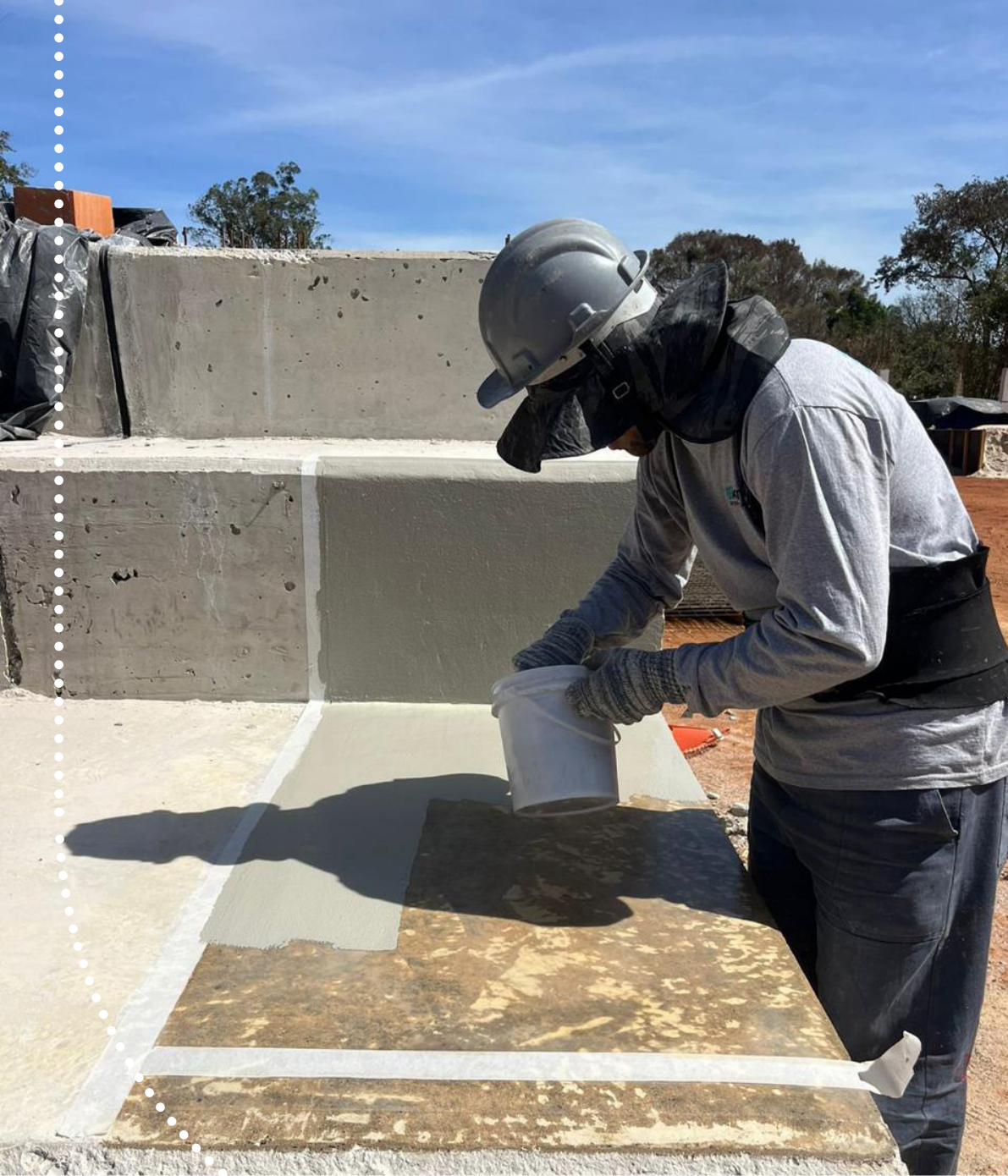
Acabamento: Aplicação do acabamento PMMA
